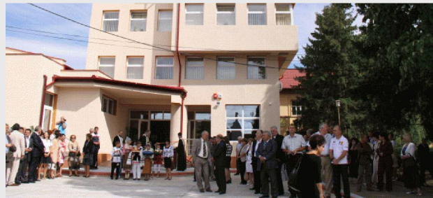
Școala „Paul Bănică” a fost reabilitată, modernizată și dotată prin Regio
